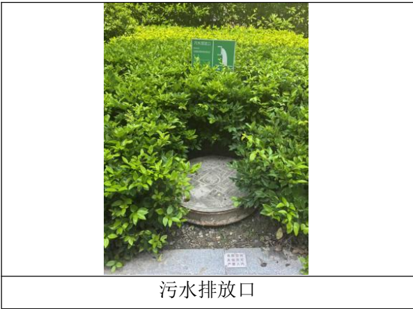
图 3-4 污水排放口现场图
